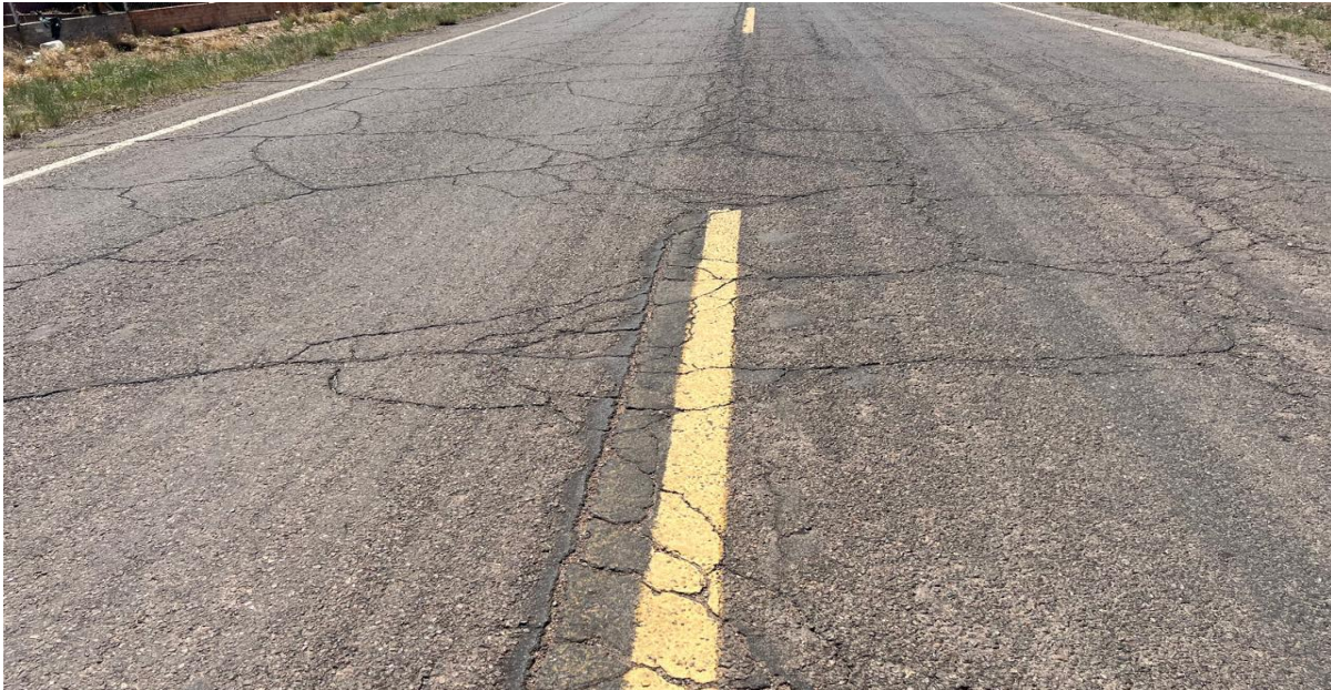
Figura No. 6. Vista del grado de deterioro que presenta el pavimento en Colonia Juárez – Colonia Cuauhtémoc
