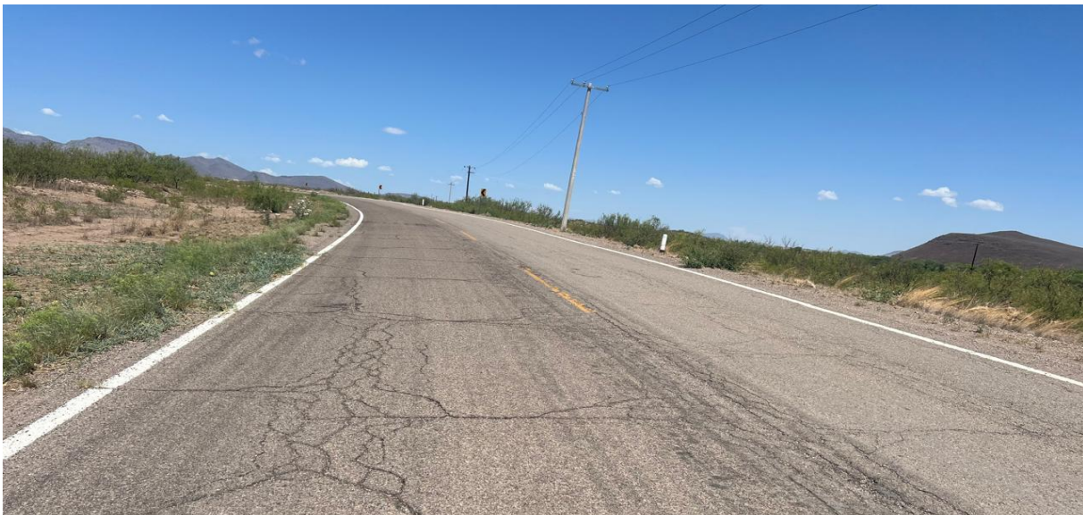
Figura No. 7. Vista del grado de deterioro que presenta el pavimento en Ramal a Ex Hacienda de San Diego
