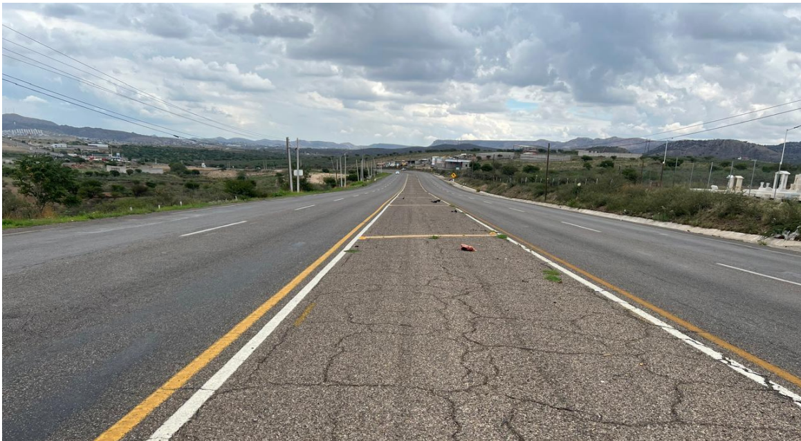
Figura No. 3. Vista del grado de deterioro que presenta el pavimento tramo: Parral – El Granillo
