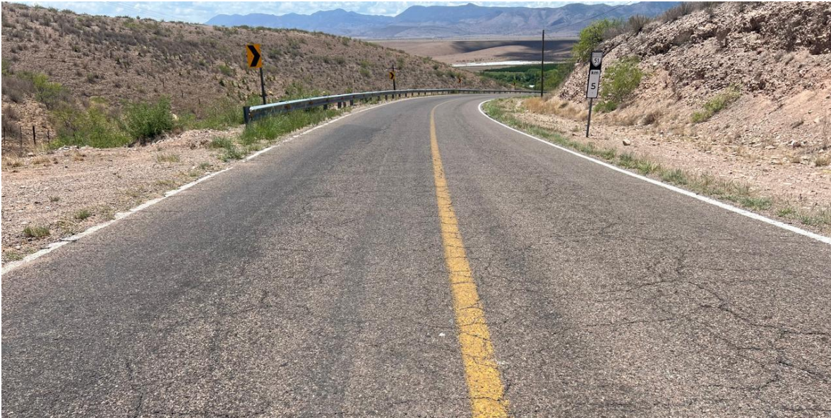
Figura No. 2. Vista del grado de deterioro que presenta el pavimento tramo: Km. 10.0 (Casas Grandes - Juan Mata Ortiz) - Col. Juárez
