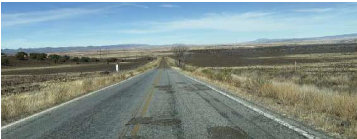
Fotografía 1. Tramo en Condiciones Aceptables en la Situación Actual
