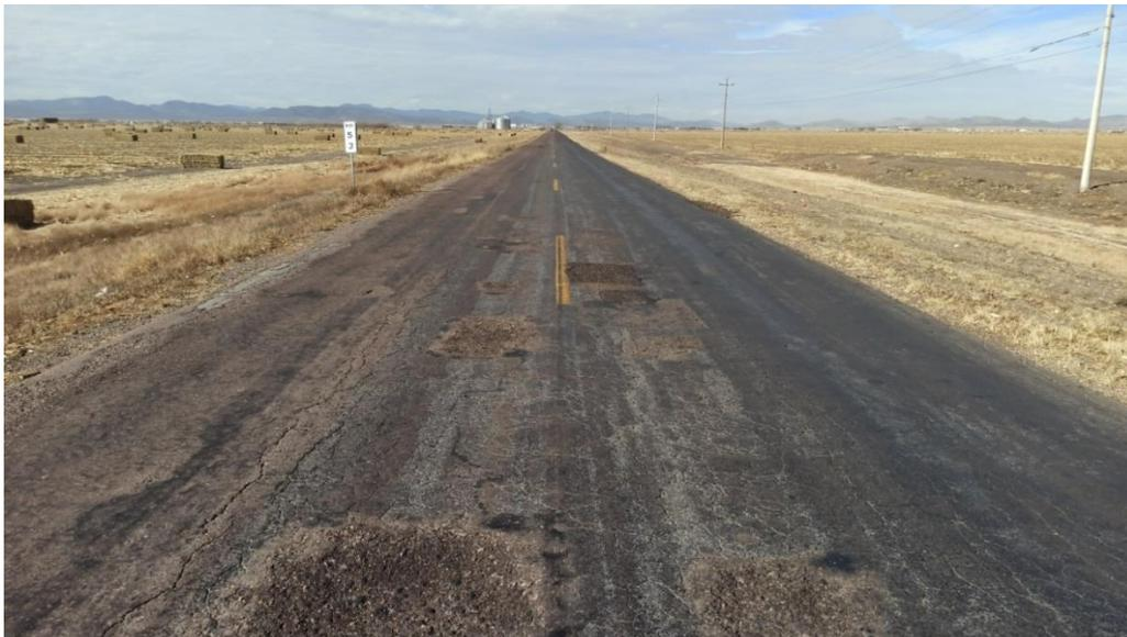
Figura No. 2. Vista del grado de deterioro que presenta el pavimento Km 53+000
