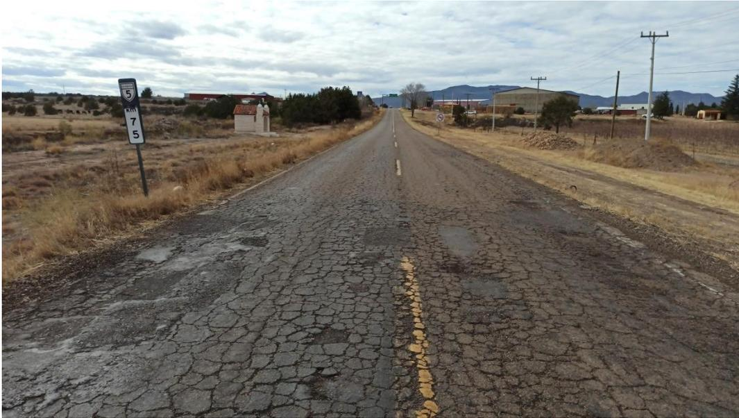
Figura No. 3. Vista del grado de deterioro que presenta el pavimento Km 75+000
