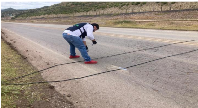
IMG. 70. Colocación e instalación de equipos de aforo automáticos en tramo C. I Griega – Santa Bárbara.
