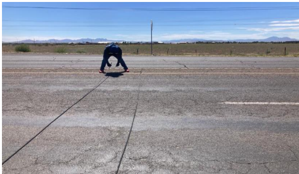
IMG. 72. Colocación e instalación de equipos de aforo automáticos en tramo C. Libramiento Gómez Morín en Nuevo Casas Grandes.
