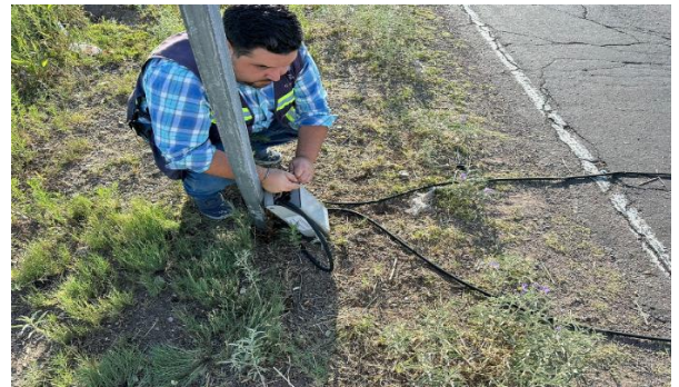
IMG. 68. Colocación e instalación de equipos de aforo automáticos en tramo C. Delicias – Rosales.
