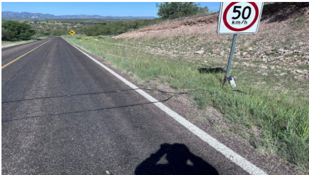
IMG. 66. Colocación e instalación de equipos de aforo automáticos en tramo C. San Francisco de Borja – Nonoava
