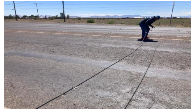
IMG. 72. Colocación e instalación de equipos de aforo automáticos en tramo C. Libramiento Gómez Morín en Nuevo Casas Grandes.
