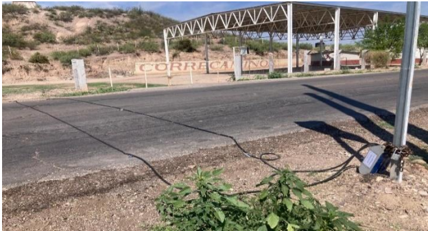
IMG. 64. Colocación e instalación de equipos de aforo automáticos en tramo C. Anáhuac – Cuauhtémoc (Oeste – Este)
