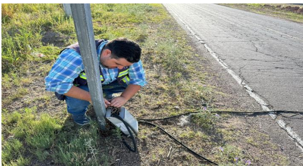
IMG. 69. Colocación e instalación de equipos de aforo automáticos en tramo C. Km. 166.9 (Jiménez – Chihuahua) – Lázaro Cárdenas – La Regina.
