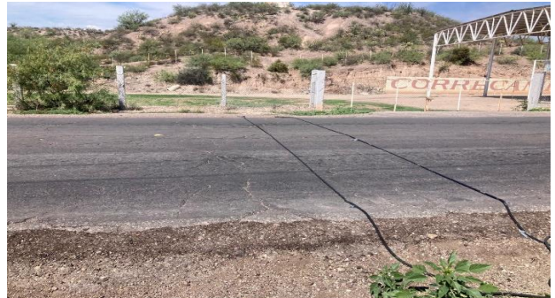
IMG. 64. Colocación e instalación de equipos de aforo automáticos en tramo C. Anáhuac – Cuauhtémoc (Oeste – Este)
