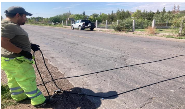
IMG. 65. Colocación e instalación de equipos de aforo automáticos en tramo C. Meoqui – Julimes.
