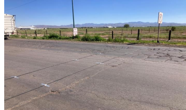
IMG. 72. Colocación e instalación de equipos de aforo automáticos en tramo C. Libramiento Gómez Morín en Nuevo Casas Grandes.
