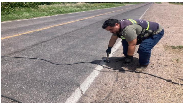
IMG. 67. Colocación e instalación de equipos de aforo automáticos en tramo Km. 132.3 (Jiménez – Chih) – Las Varas.
