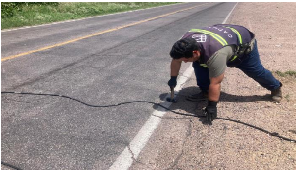
IMG. 66. Colocación e instalación de equipos de aforo automáticos en tramo C. San Francisco de Borja – Nonoava
