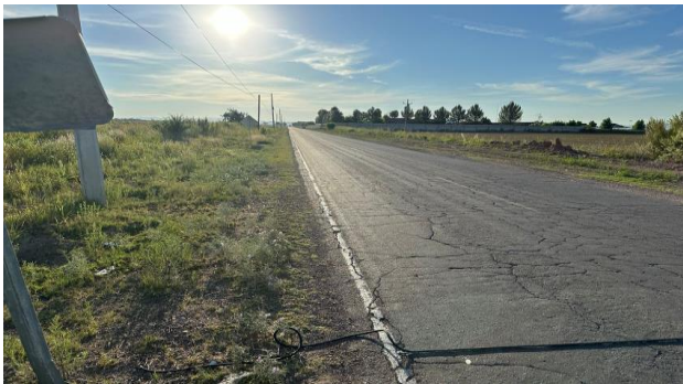
IMG. 68. Colocación e instalación de equipos de aforo automáticos en tramo C. Delicias – Rosales.
