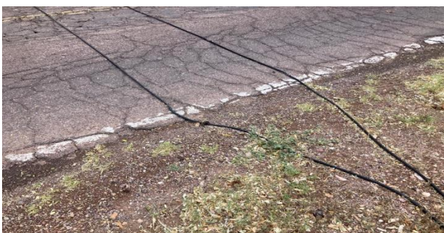
IMG. 71. Colocación e instalación de equipos de aforo automáticos en tramo C. Delicias – Presa Francisco I. Madero Tramo: Ent. a Satevó – Presa Francisco I. Madero
