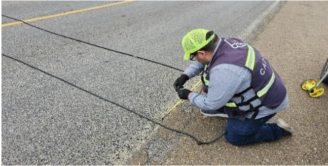
IMG. 62. Colocación e instalación de equipos de aforo automáticos en tramo Km 5.0 (Cuauhtémoc – Tomochi – Carichi).
