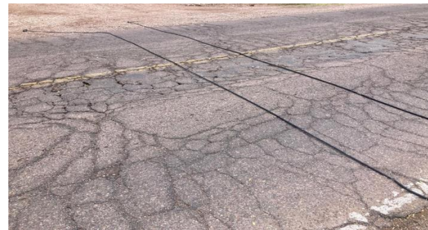
IMG. 71. Colocación e instalación de equipos de aforo automáticos en tramo C. Delicias – Presa Francisco I. Madero Tramo: Ent. a Satevó – Presa Francisco I. Madero
