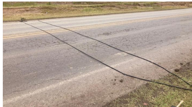
IMG. 70. Colocación e instalación de equipos de aforo automáticos en tramo C. I Griega – Santa Bárbara.
