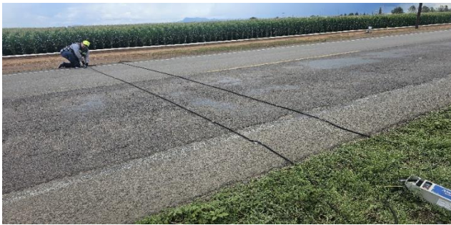
IMG. 64. Colocación e instalación de equipos de aforo automáticos en tramo C. Anáhuac – Cuauhtémoc (Oeste – Este)
