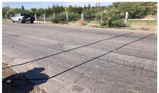
IMG. 65. Colocación e instalación de equipos de aforo automáticos en tramo C. Meoqui – Julimes.
