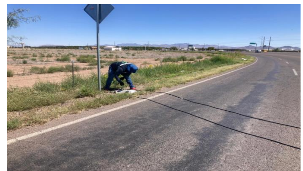
IMG. 73. Colocación e instalación de equipos de aforo automáticos en tramo C. Nuevo Casas Grandes – Casas Grandes
