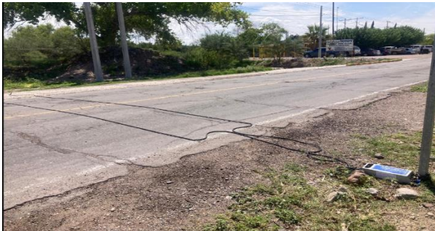
IMG. 68. Colocación e instalación de equipos de aforo automáticos en tramo C. Delicias – Rosales.
