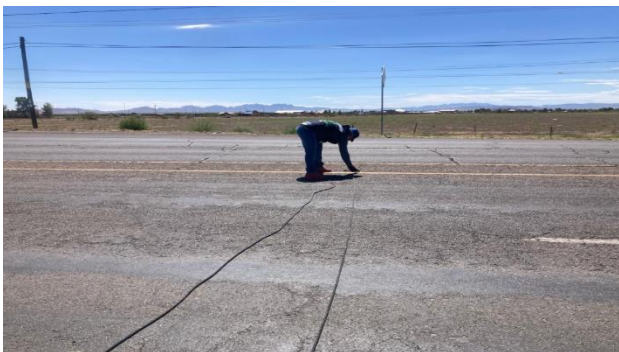
IMG. 73. Colocación e instalación de equipos de aforo automáticos en tramo C. Nuevo Casas Grandes – Casas Grandes
