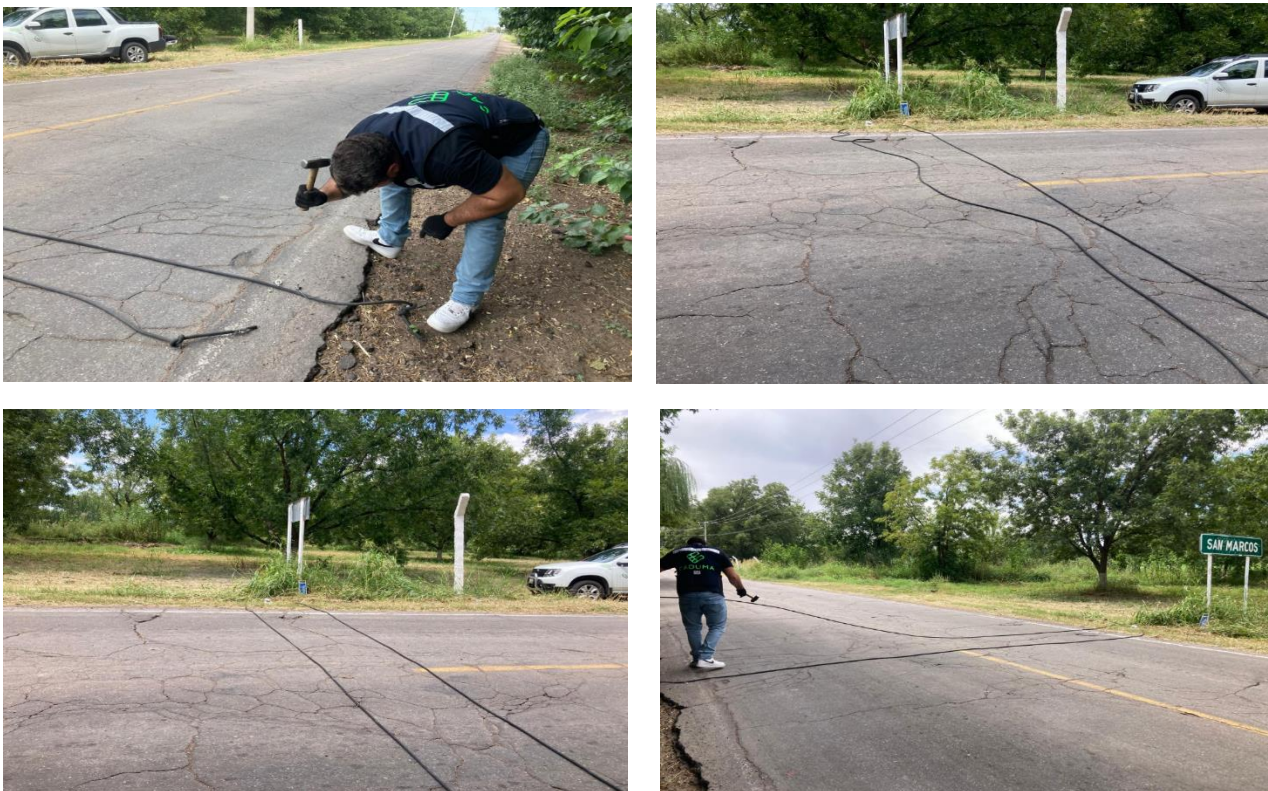
IMG. 53. Colocación e instalación de equipos de aforo automáticos en tramo C. Delicias – Saucillo.
