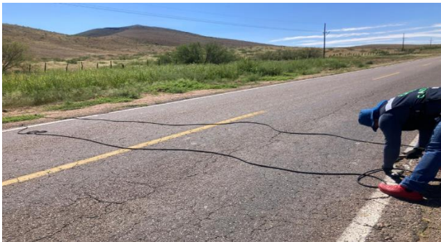
IMG. 58. Colocación e instalación de equipos de aforo automáticos en tramo C. Casas Grandes – Juan Mata Ortíz.
