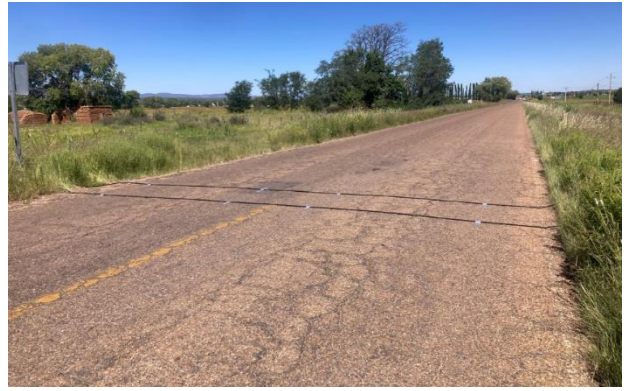
IMG. 54. Colocación e instalación de equipos de aforo automáticos en tramo C. Guerrero – Matachí.
