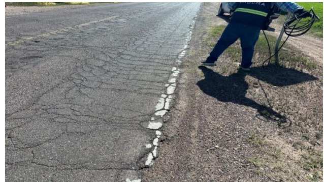
IMG. 50. Colocación e instalación de equipos de aforo automáticos en tramo C. Libramiento Gómez Morín en Cuauhtémoc.
