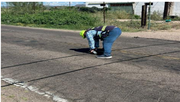
IMG. 51. Colocación e instalación de equipos de aforo automáticos en tramo C. Meoqui – Rosales – Presa Francisco I. Madero.
