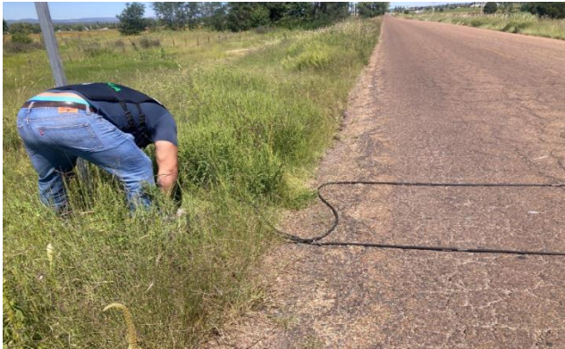
IMG. 54. Colocación e instalación de equipos de aforo automáticos en tramo C. Guerrero – Matachí.
