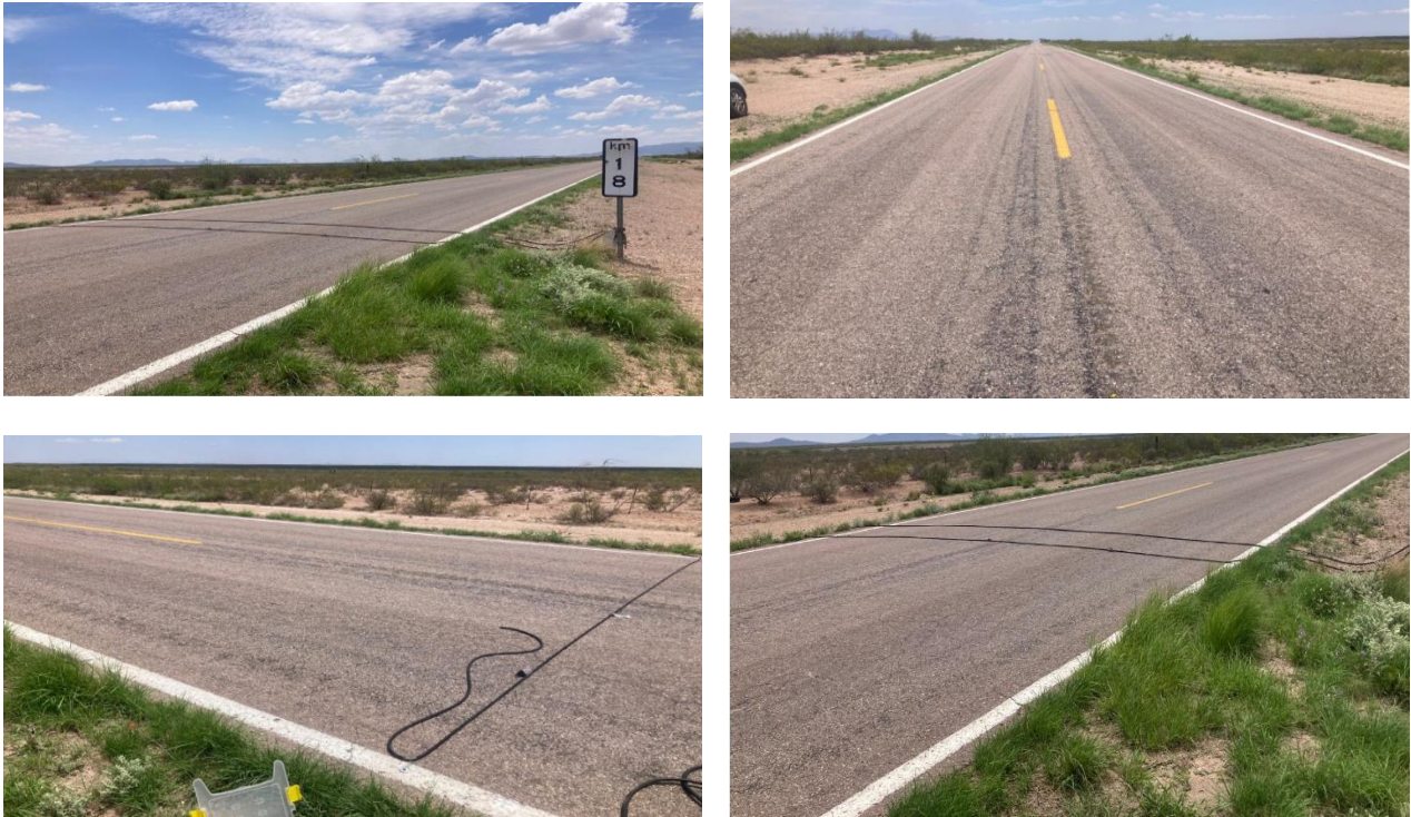
IMG. 52. Colocación e instalación de equipos de aforo automáticos en tramo C. Delicias – Naica
