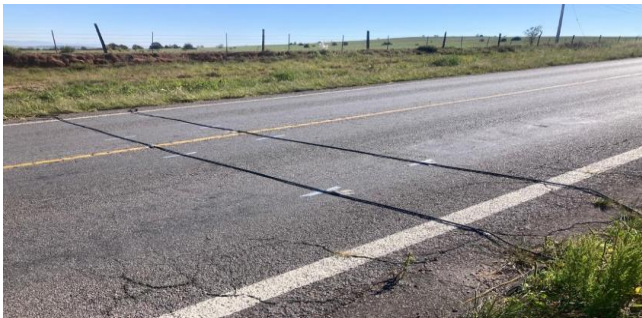
IMG. 56. Colocación e instalación de equipos de aforo automáticos en tramo C. La Casita – Balleza.
