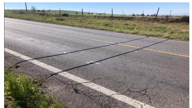
IMG. 57. Colocación e instalación de equipos de aforo automáticos en tramo C. Km. 62.0 (Chihuahua – Juárez) – El Terrero
