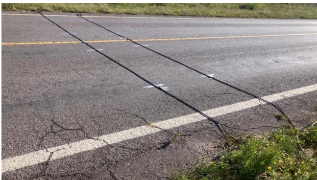
IMG. 57. Colocación e instalación de equipos de aforo automáticos en tramo C. Km. 62.0 (Chihuahua – Juárez) – El Terrero
