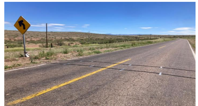
IMG. 58. Colocación e instalación de equipos de aforo automáticos en tramo C. Casas Grandes – Juan Mata Ortíz.
