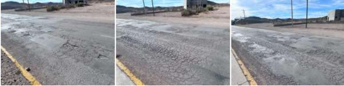
*Imagen 30.- Zonas agrietadas en la Carretera (Piel de cocodrilo) a falta de riego de sello.*
