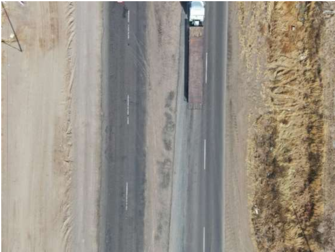
Imagen 28.- Sección vial Carretera Cuauhtémoc - Álvaro Obregón (vista aérea)
