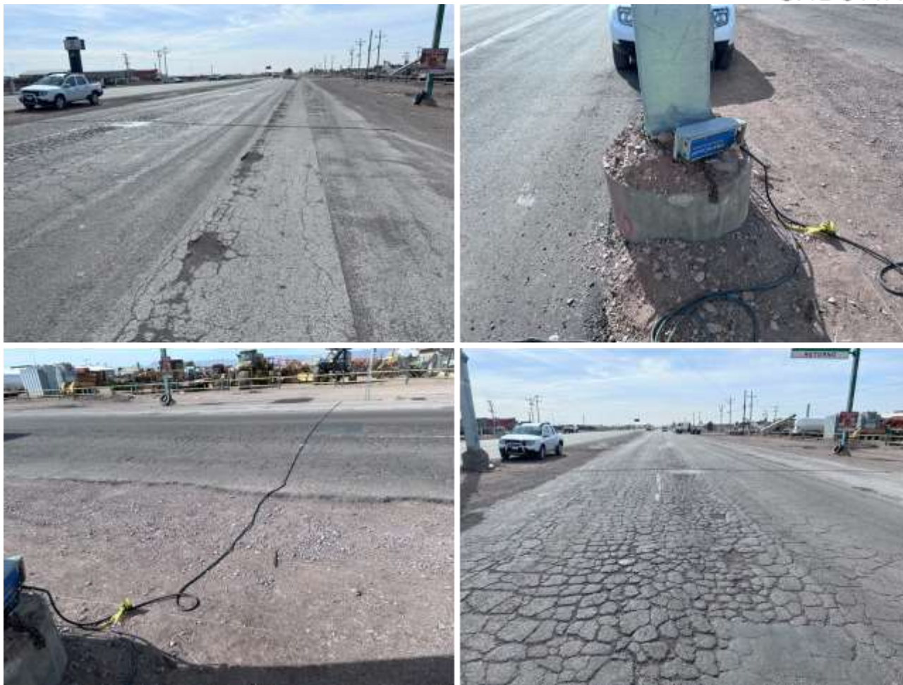
Imagen 21 Colocación e instalación de equipos de aforo automáticos en la zona. Fuente: Archivos de fotografías de campo
