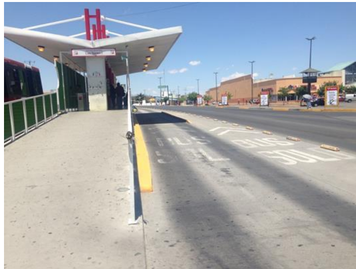
Figura 2-29 Acceso a la estación Las Torres I
