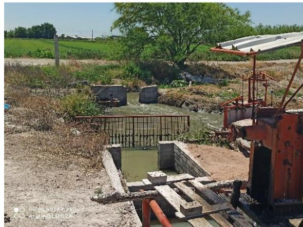
Figura 15. Caja unión. Fuente: APIA Ingeniería.
