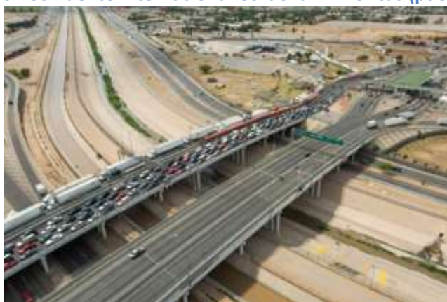
Ilustración 66 Puente Internacional Córdoba - Américas (puente libre)
